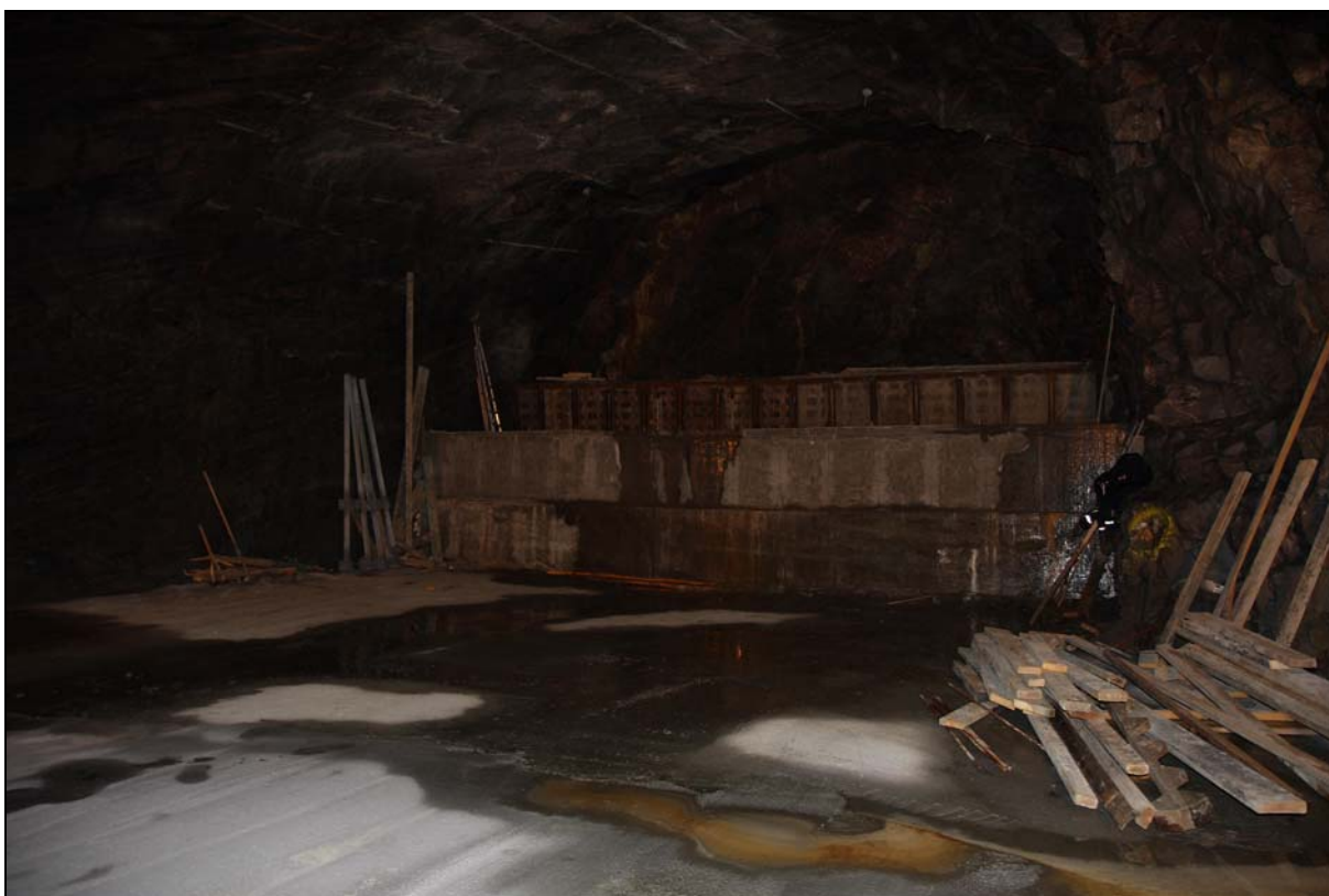
Fig. 10: Første og andre forsøndelse ferdig innstøpt i tre "høyder".
