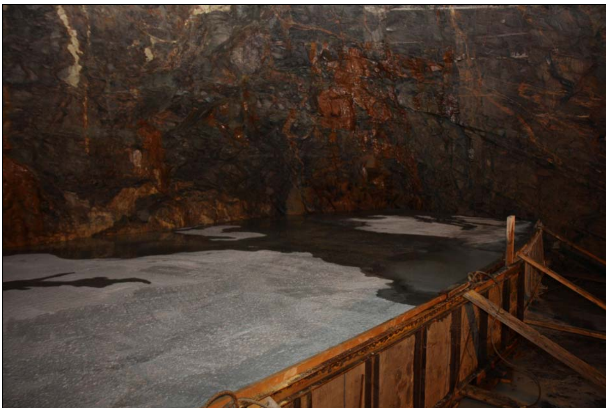
Fig. 9: Første forsøndelse ferdig innstøpt og deponert.
