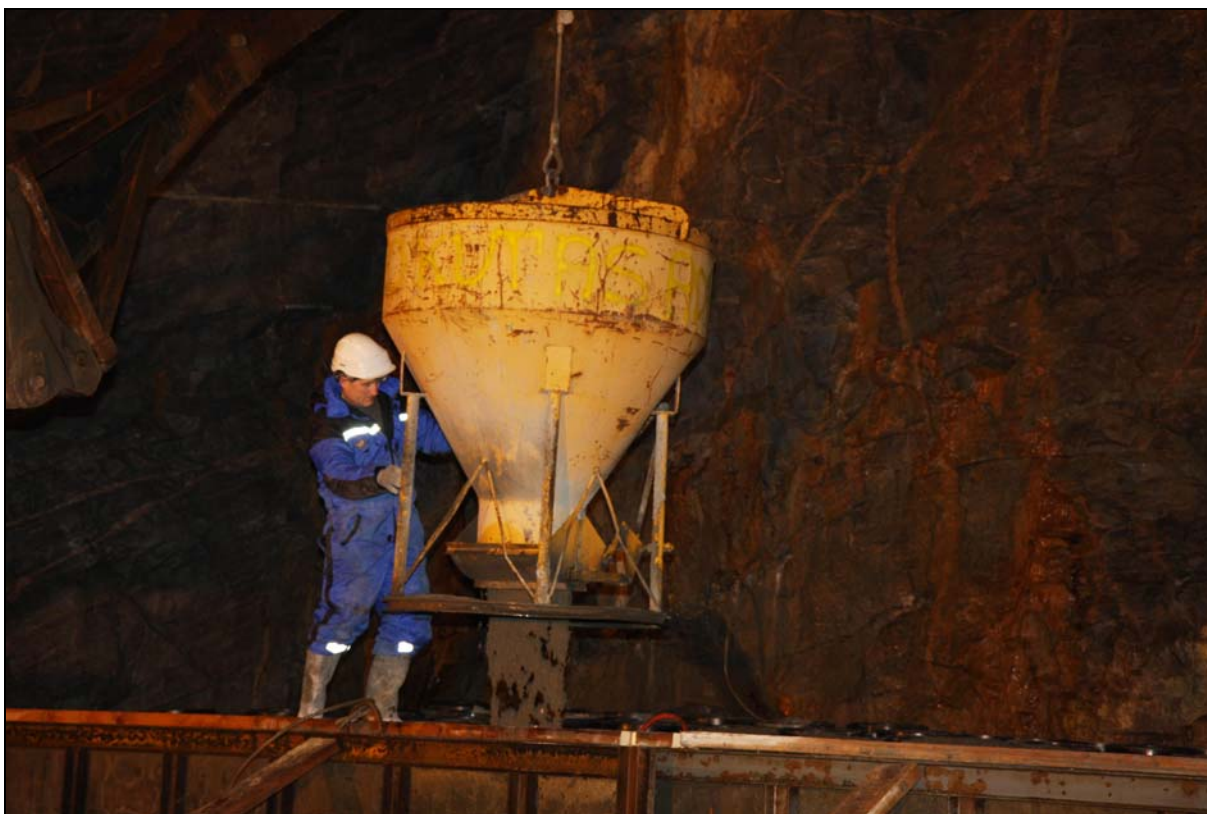
Fig. 7: Omstøping av LRA-fat fra første forsendelse.
