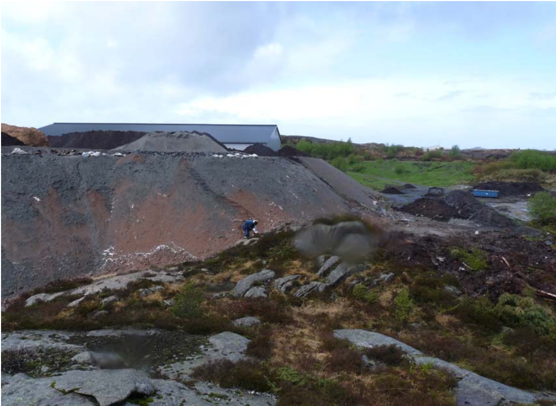
Høyre halvdel av deponiet med bygning for kompostanlegg i bakgrunnen
