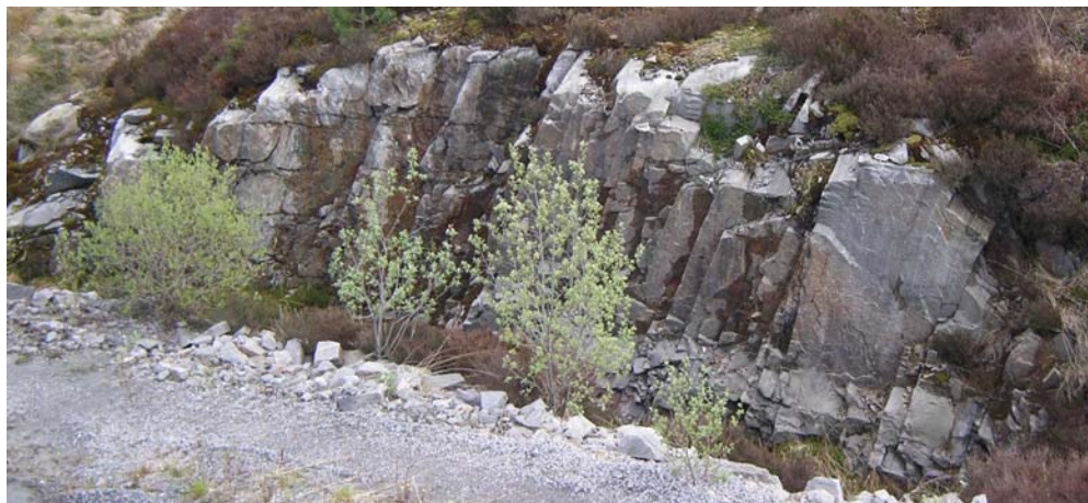
Foto 3 Nordlig del av utsprengt drengroft med kanter preget av både foliasjon (på tvers av grøften) og tverrsprekker (i spiss vinkel til grøften).
