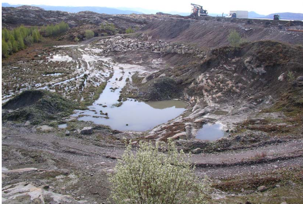
Foto 1 Oversikt over nordsiden av fjellryggen, som går langs planlagt tunnel.
