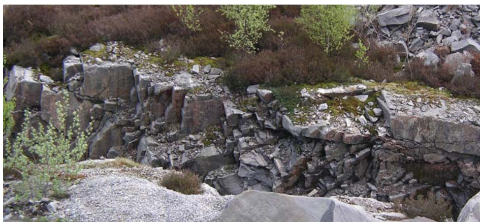
Foto 4 Sørlig del av utsprengt drengroft med kanter preget av både foliasjon og tverrsprekker, samt noen horisontale sprekker.
